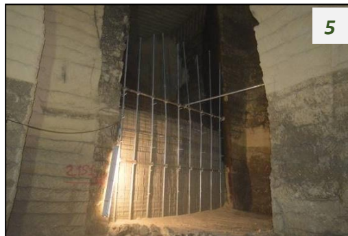
Figura 2: Ingresso dell'operatore in cavità dal pozzo di accesso per ispezioni Figura 3: Rilievo topografico delle cavità mediante Stazione Totale Figura 4 e 5: Parete di sbarramento progetto e realizzazione
