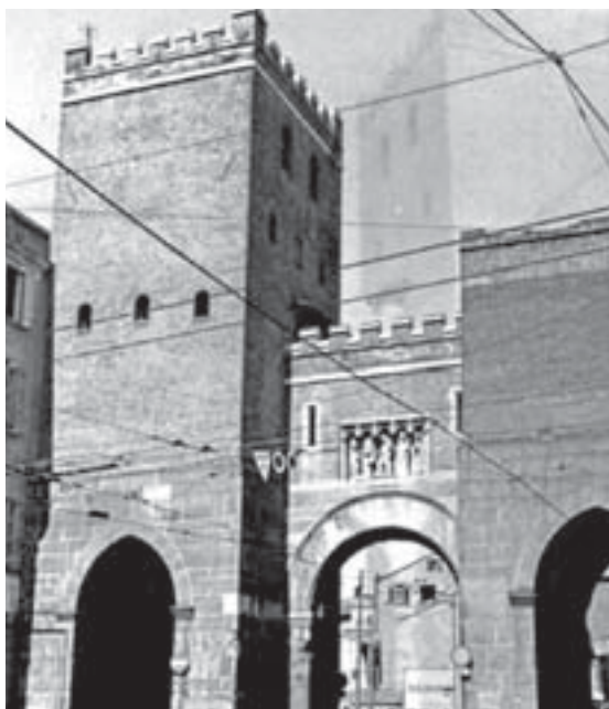
7-8. Porta Ticinese a Milano, prima e dopo il restauro del 1861.
