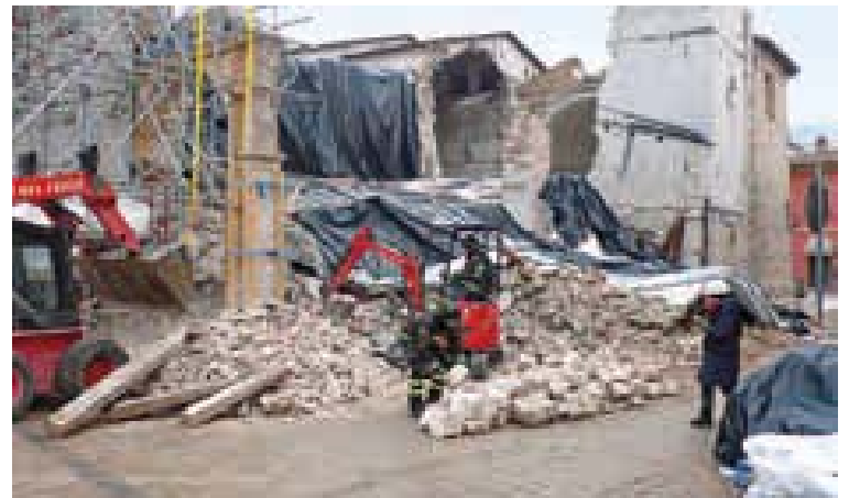
Fig. 8. Le squadre al lavoro sulle frange del crollo (foto di M.E. Corrado, 2017).
